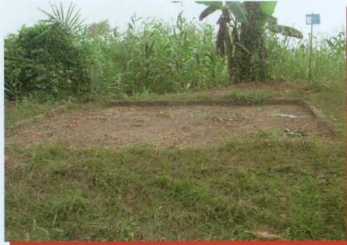
Aire de collecte cimentée
